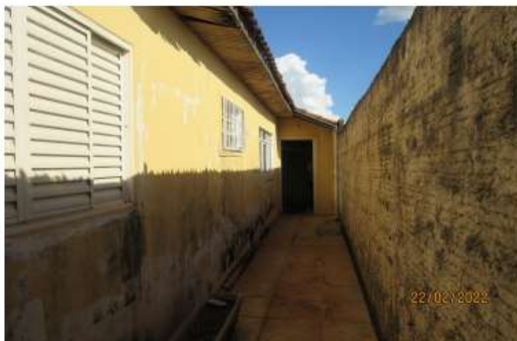
FOTO Nº 14 Vista geral da área livre dos fundos
