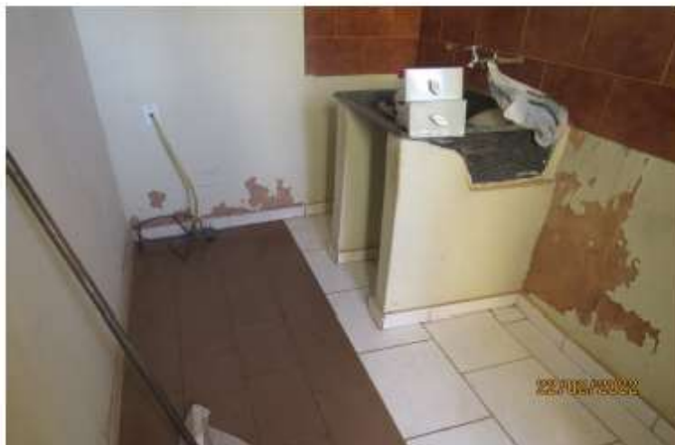
FOTO Nº 17 Aspecto geral da área de serviços
