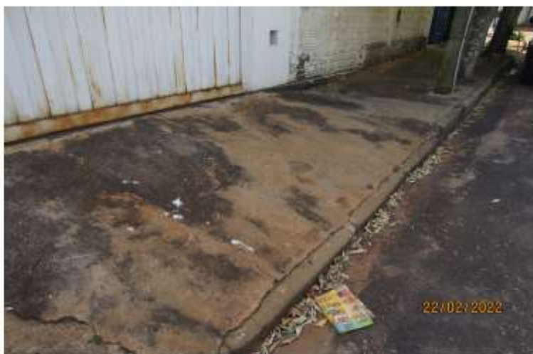
FOTO N° 4 Rampa de acesso parte residencial
