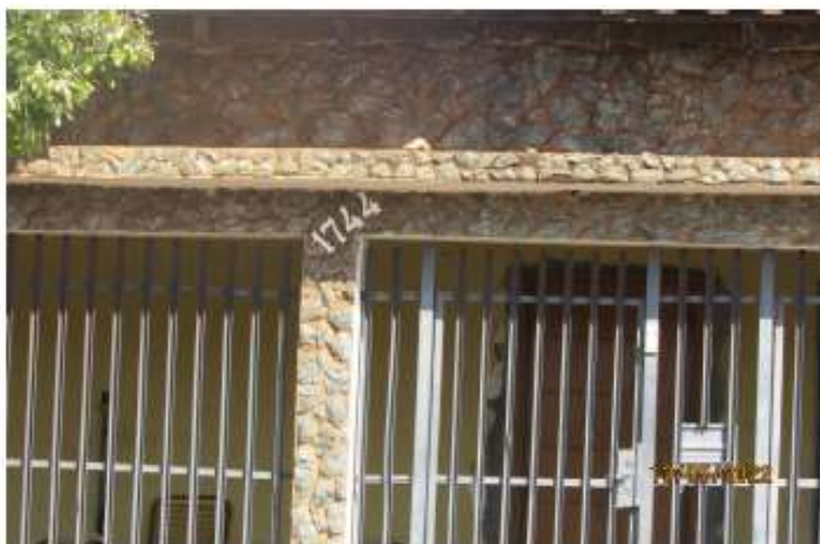
FOTO Nº 4 Vista frontal mais próxima - numeral e gradil
