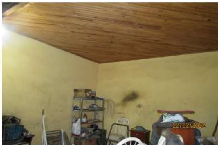
FOTO Nº 7 Área comercial - forro e paredes
