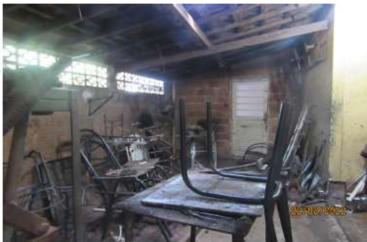
FOTO N° 5 Vista interna parcial da área comercial - frente sem forro
