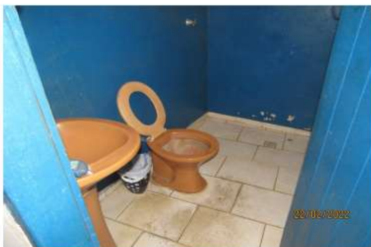
FOTO Nº 9 Banheiro área comercial
