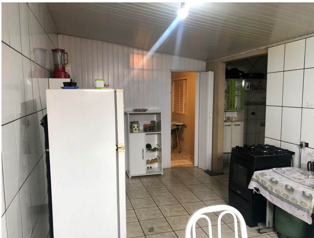
18. Cozinha, área ampliada e não regularizada junto à Prefeitura de Marília.
