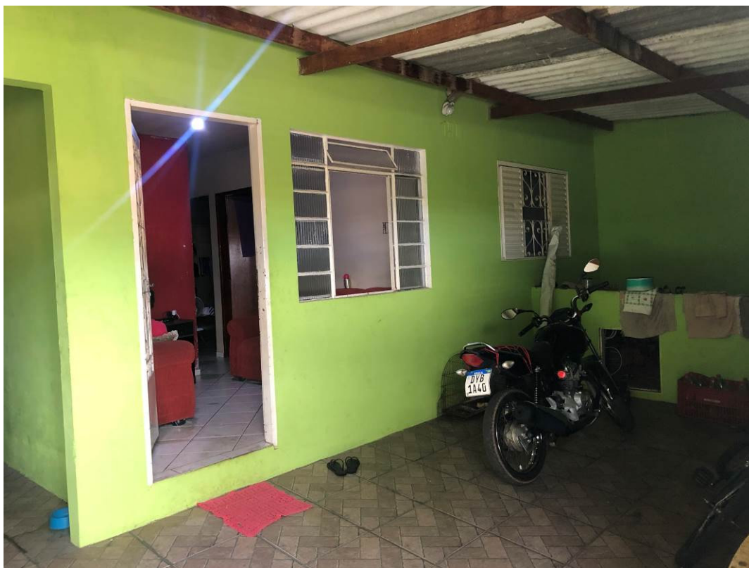
8. Vista da área coberta, que não está regularizada junto à Prefeitura.
