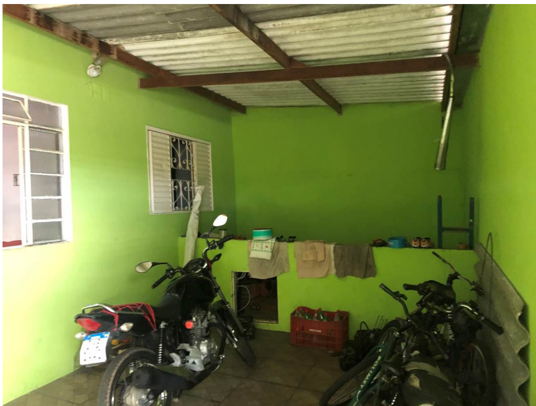
9. Vista da área coberta, que não está regularizada junto à Prefeitura.
