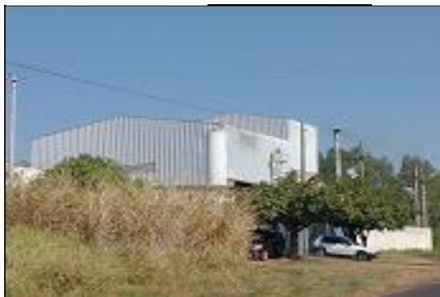
VISTA DE FRETE DO IMÓVEL
