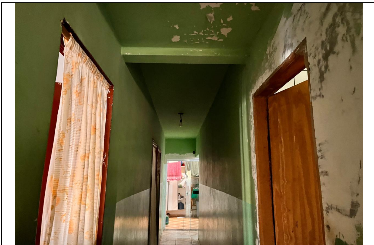
Foto 7: Vista do corredor interno do imóvel avaliado.
