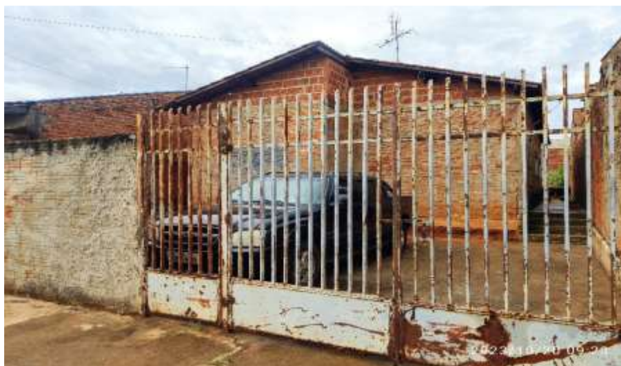
Fachada do imóvel sito a Rua João Bossonaro nº 1.490
