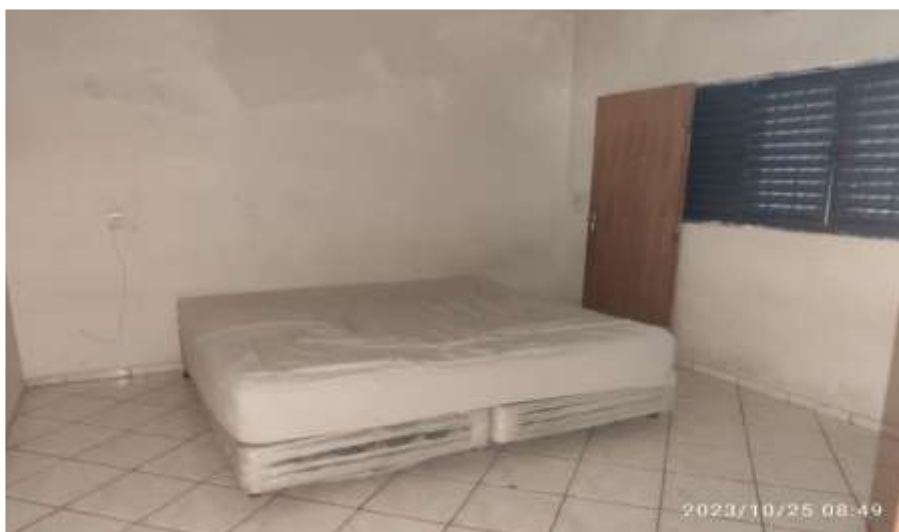
Esta foto comprova a conservação do imóvel
