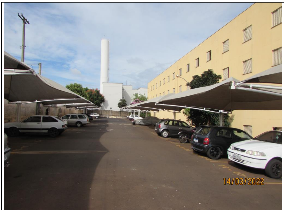
FOTO 04: Estacionamento, tendo a Torre 2 à direita.
