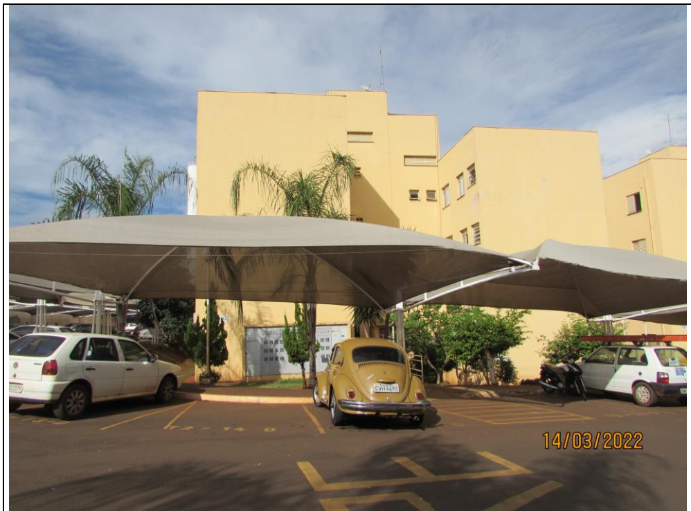
FOTO 03: Vista da Torre 2.
