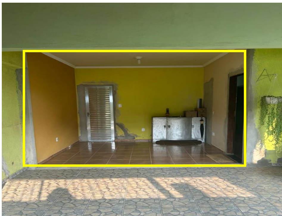
(Vista Garagem com detalhe da parede suprimida)
