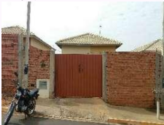
21° 15' 11,77" S 48° 31' 18,58" O Avenida Engenheiro Wilian Cestari, 1660
