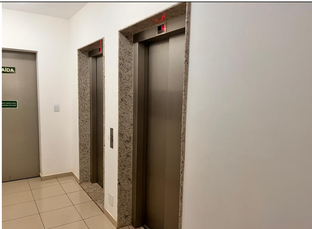
Foto 4: Vista do corredor dos elevadores. Sendo dois elevadores, um de serviço e um social.
