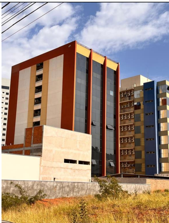
Foto 3: Vista dos fundos do prédio onde está localizado o imóvel avaliado.
