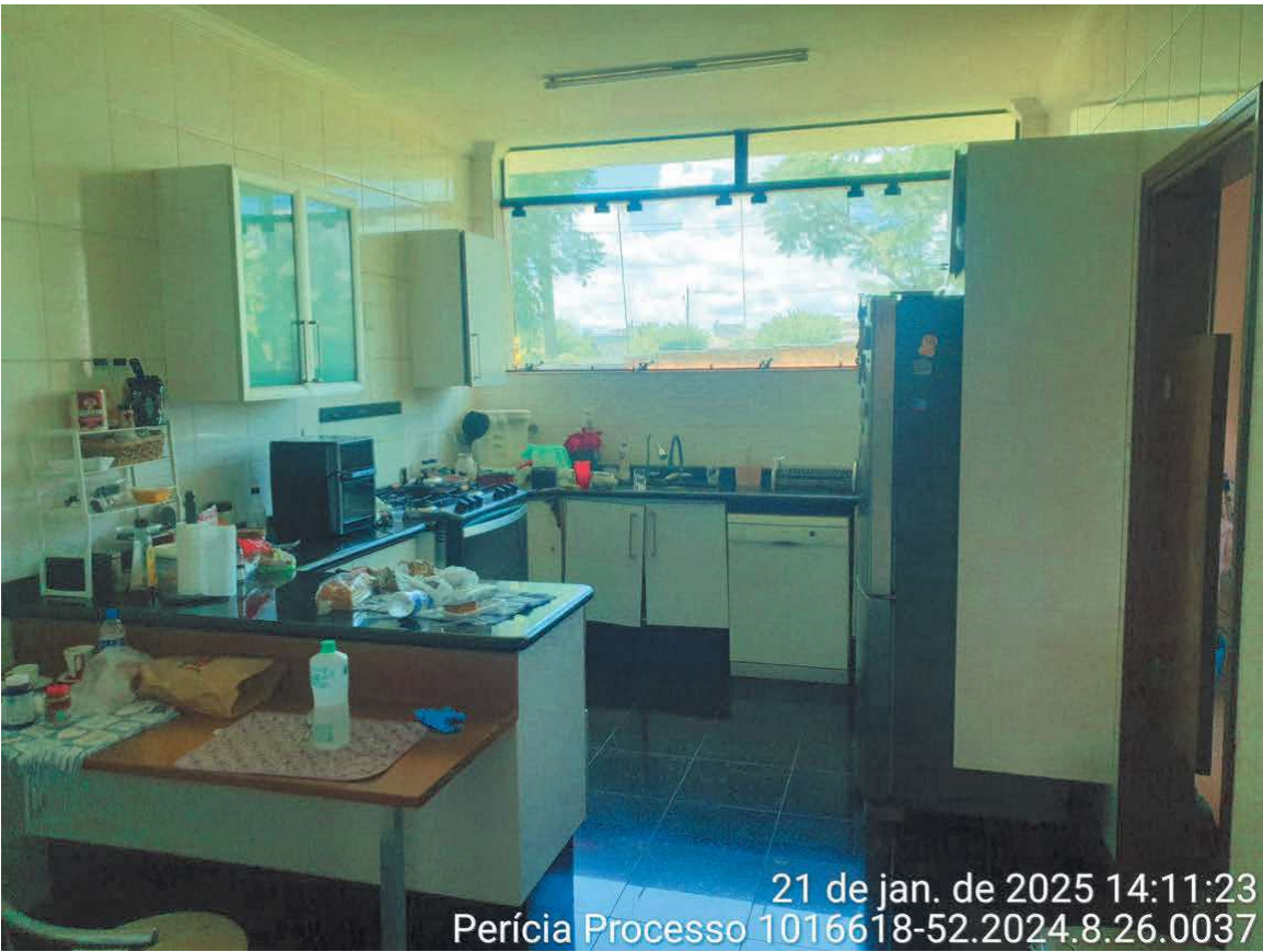
Foto 07 - Cozinha, piso ceramico, parede revestida em azulejo até a laje, esquadrias em aluminio e fechamento em vidro temperado.
