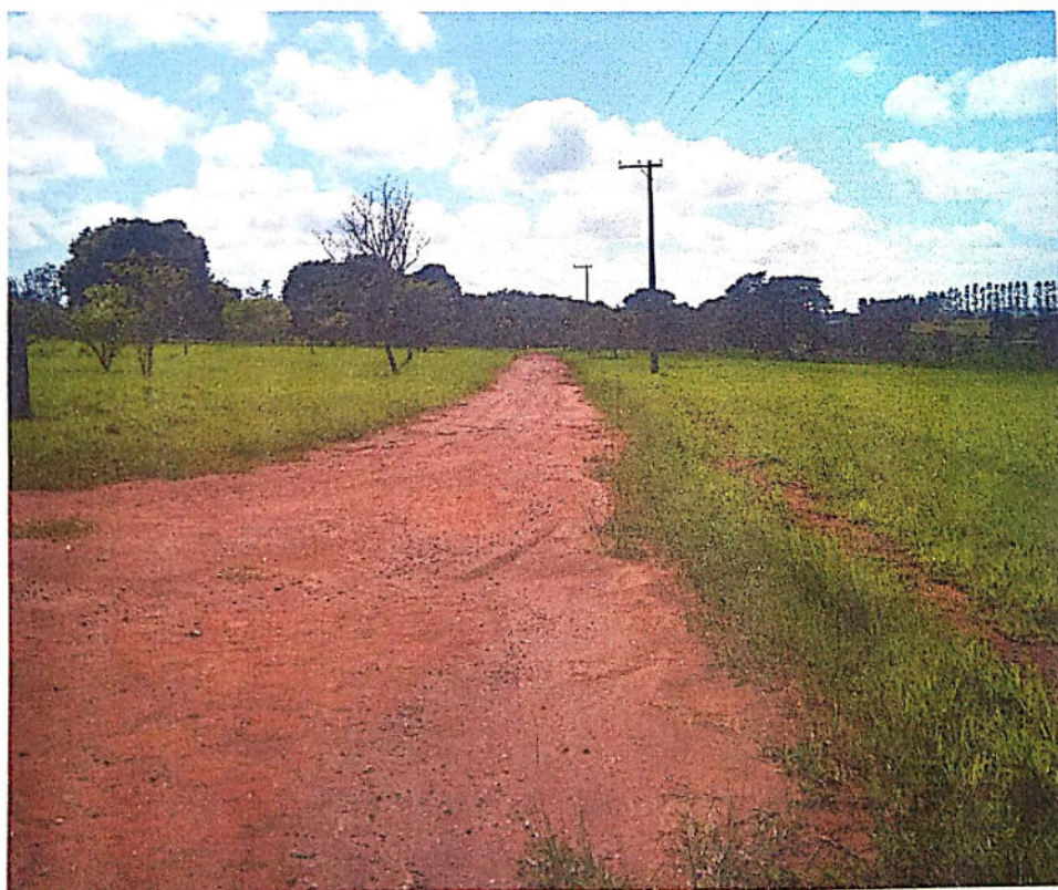
Imagem da Rua Ipaussu sem pavimentação, mostrando poste de iluminação.
