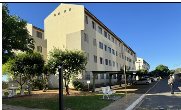
Foto 02. Vista do bloco 7
