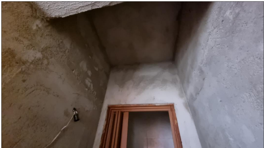
| FOTO 22: Vista geral do banheiro externo.
