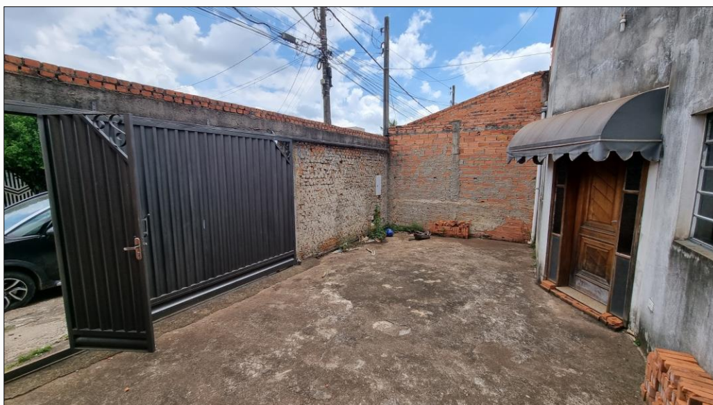
| FOTO 4: Vista geral da garagem.
