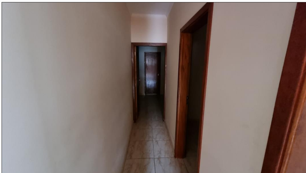
| FOTO 11: Vista geral do corredor de circulação.
