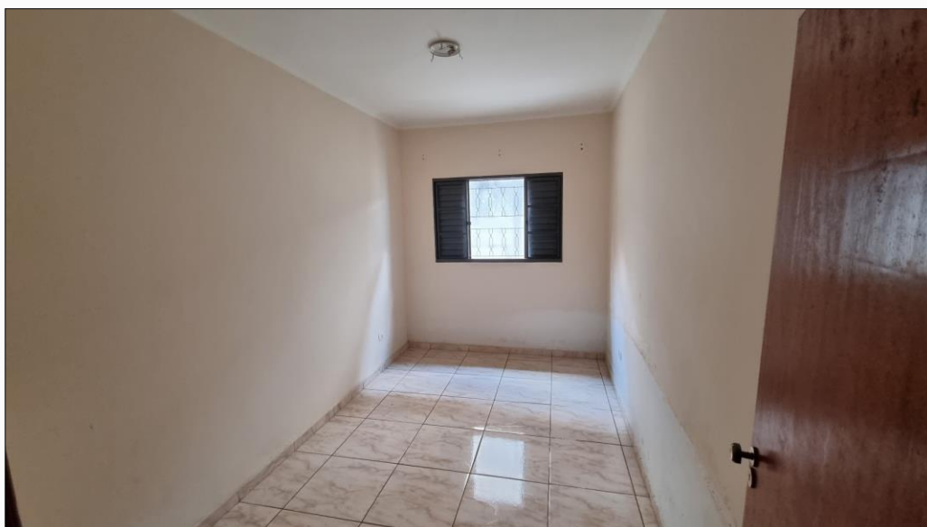
| FOTO 12: Vista geral do dormitório.
