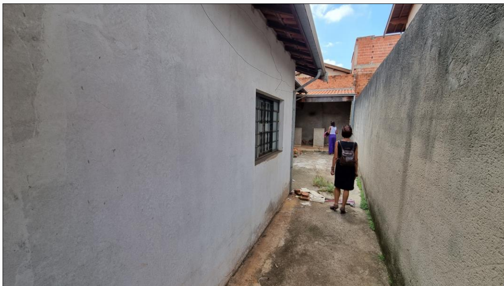
| FOTO 5: Vista geral do corredor externo
