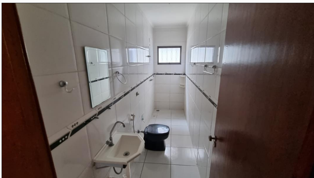
| FOTO 10: Vista geral do banheiro.
