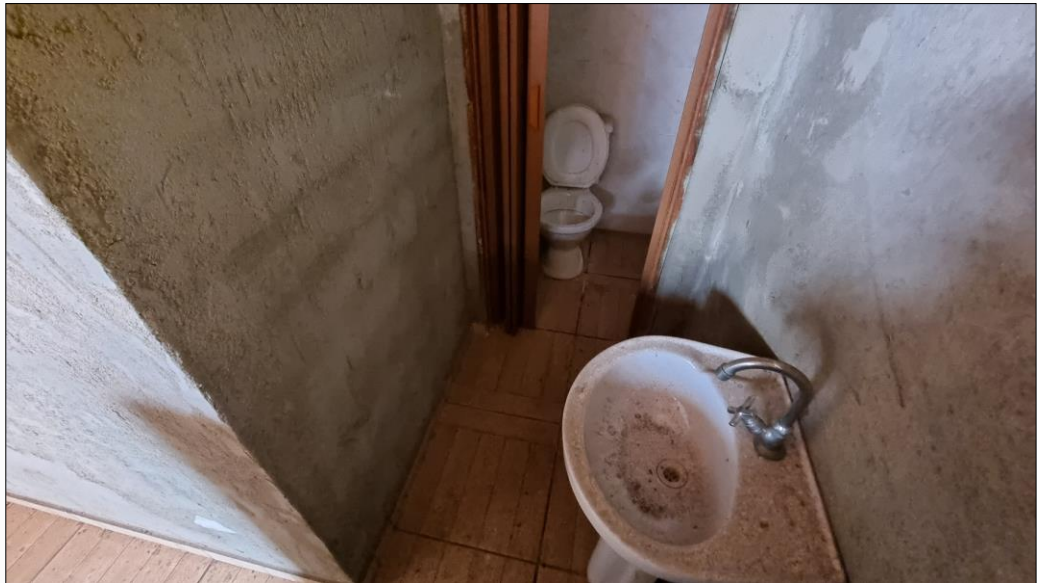
| FOTO 21: Vista geral do banheiro externo.
