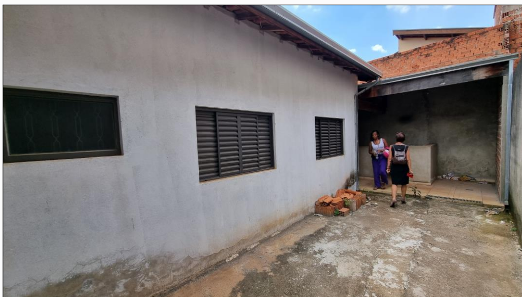
| FOTO 6: Vista geral fachada lateral.
