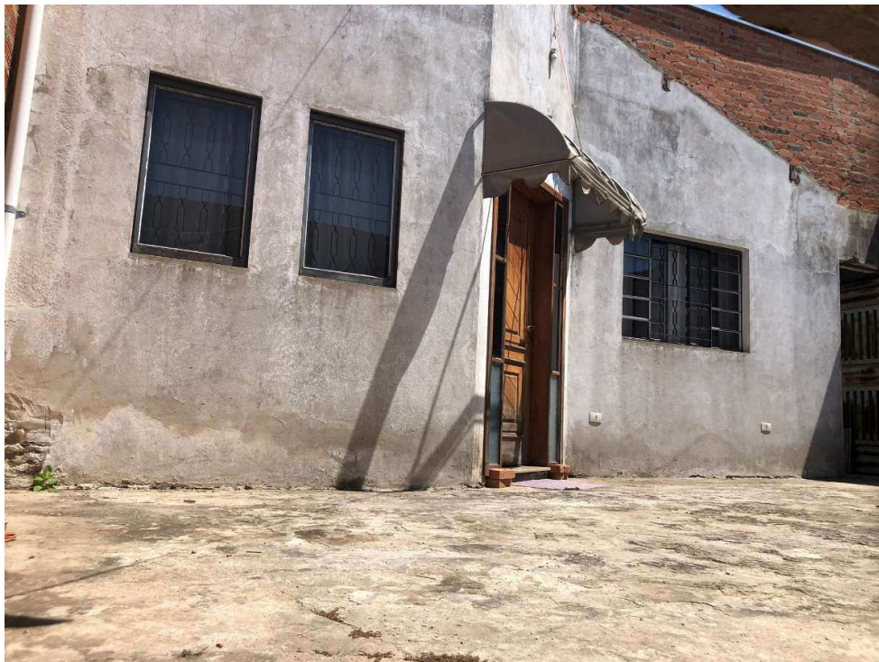
Foto 4: Vista frontal da benfeitoria existente
