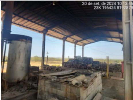
Depósito de Lenha
