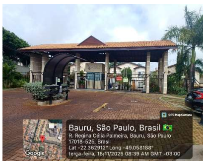
Foto 02 – Entrada do Condomínio 18.11.2025
