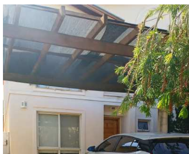
Foto 05 – Entrada do Imóvel
