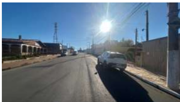
Foto 1 - Vista do logradouro e das condições de acesso.
