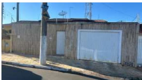
Foto 3 - Fachada frontal do imóvel avaliando.
