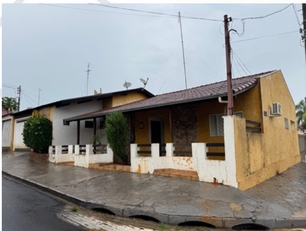
Fachada da edificação
