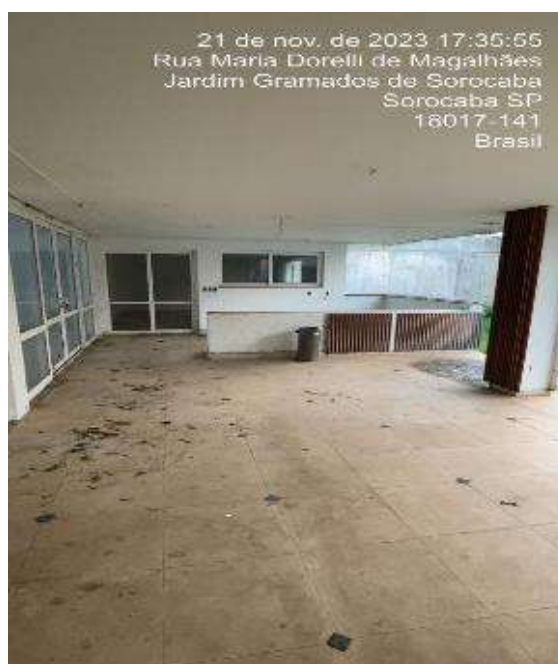
Foto 07 – Área Coberta Fundos
