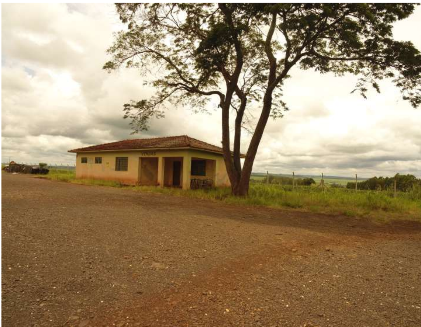
FOTOS SOLO 4, 5 e 6: Vista da EDIFICAÇÃO sobre o terrenos
