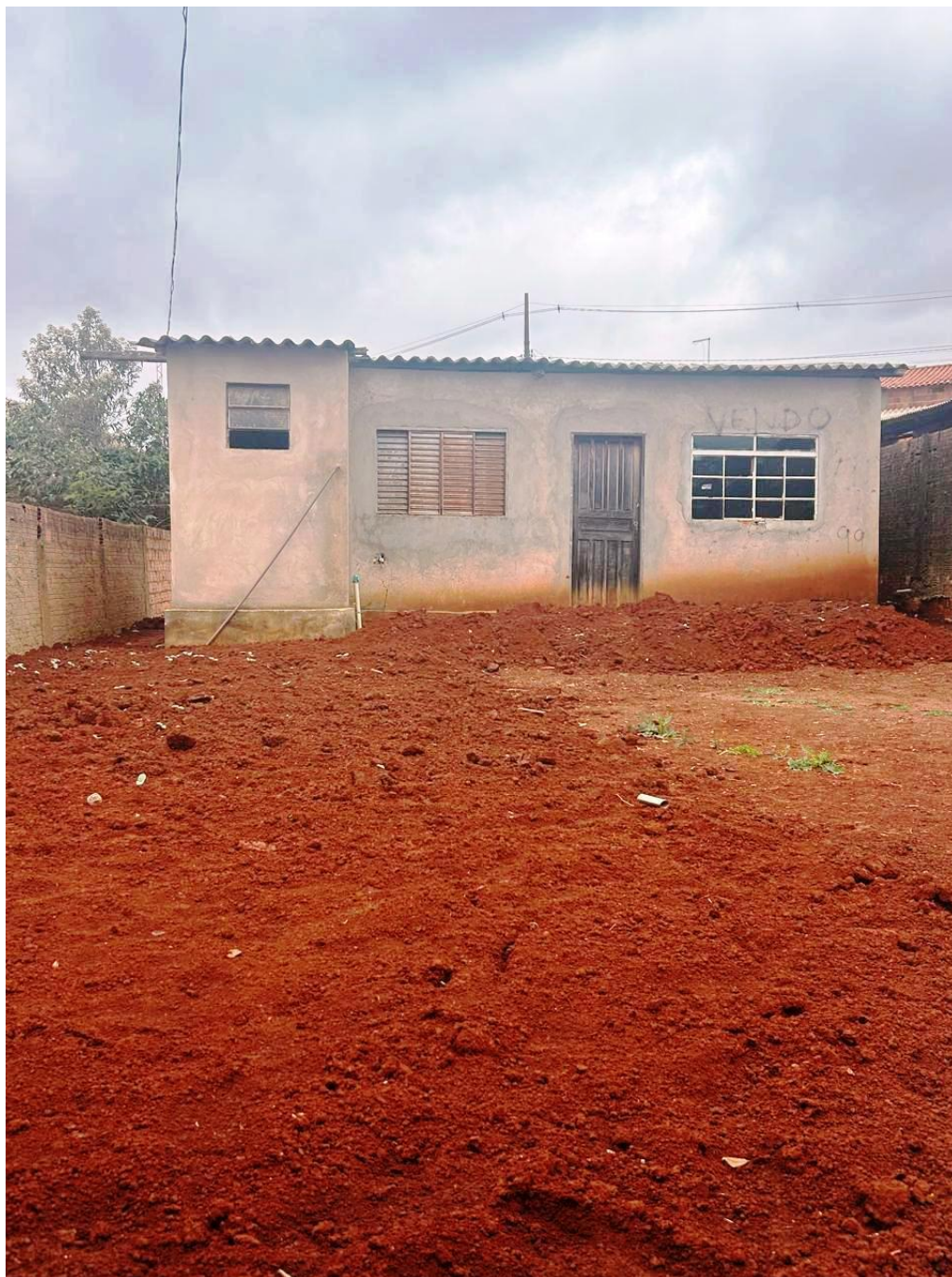
Vista externa da edificação.
