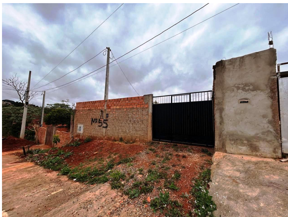
Outra vista da fachada do imóvel avaliando.
