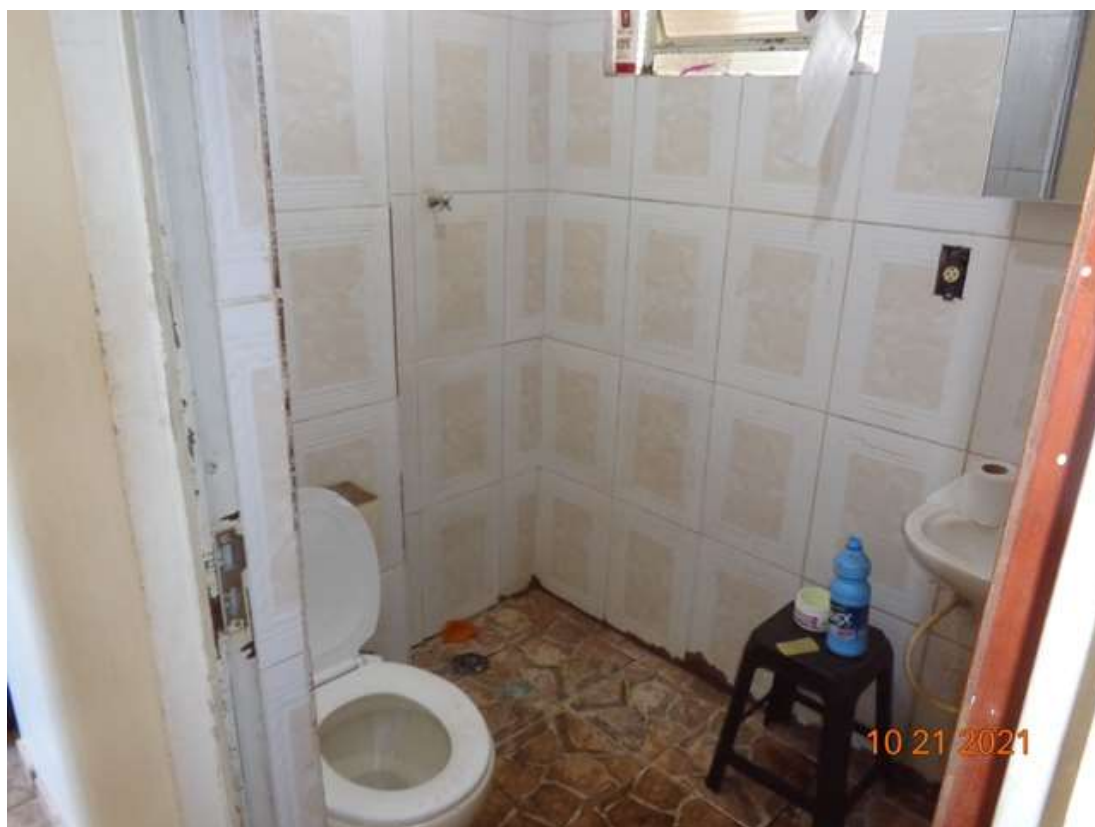
Foto 8 – Imagem do banheiro do imóvel.
