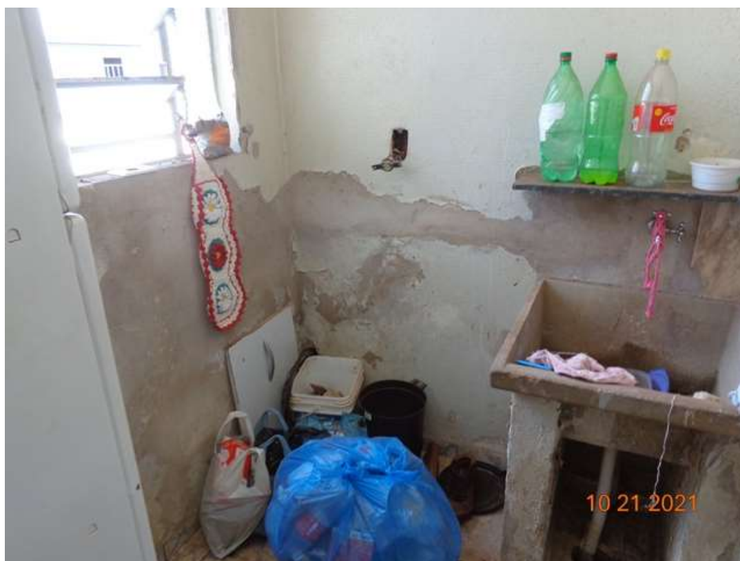
Foto 6 – Imagem da Lavanderia do imóvel com acesso pela cozinha.
