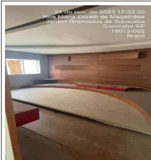
Foto 03 – Sala Pav. Inferior
