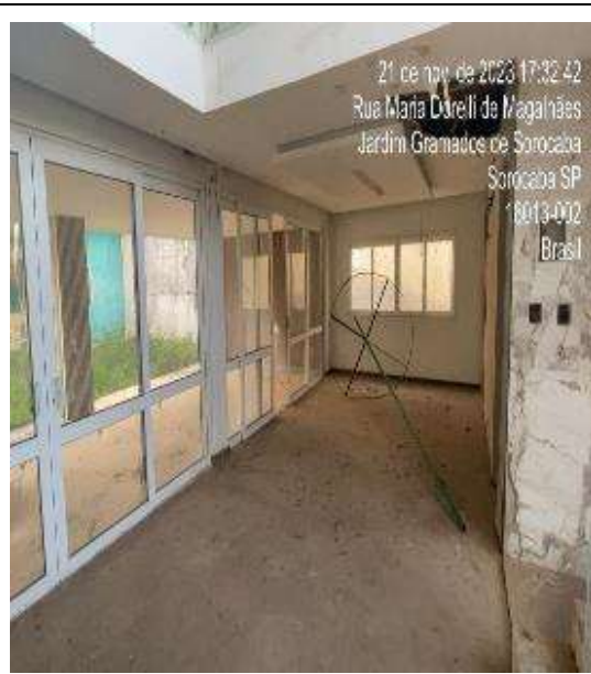
Foto 04 – Sala Acesso Fundos
