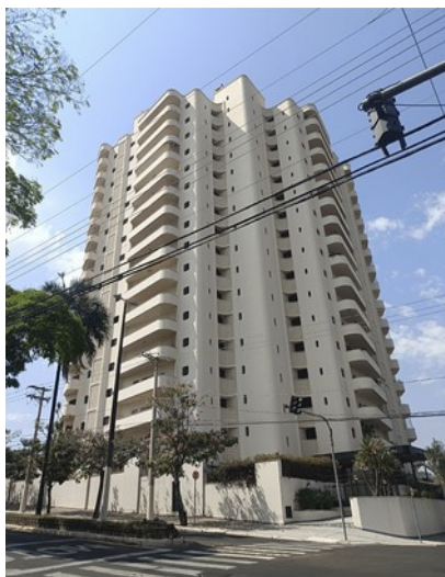
Fig. 3 Vista externa do edifício
