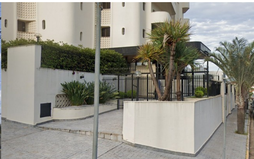
Fig. 4 Portaria sem acessibilidade
