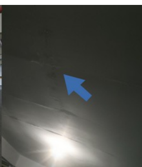
Fig. 15 Vazamento laje
