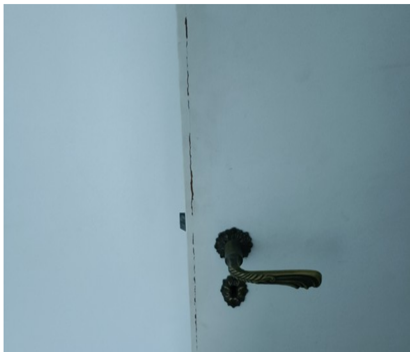
Fig. 22 Porta com deslocamento
