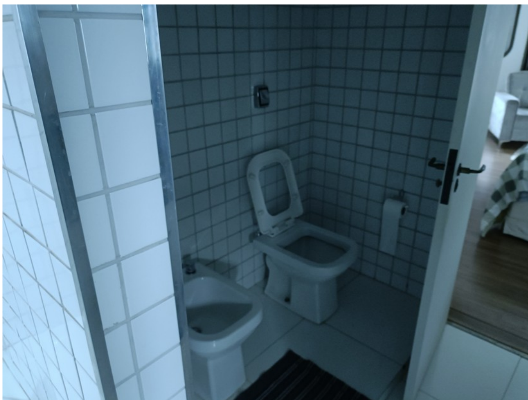
Fig. 23 Sanitário com base elevada por degrau
