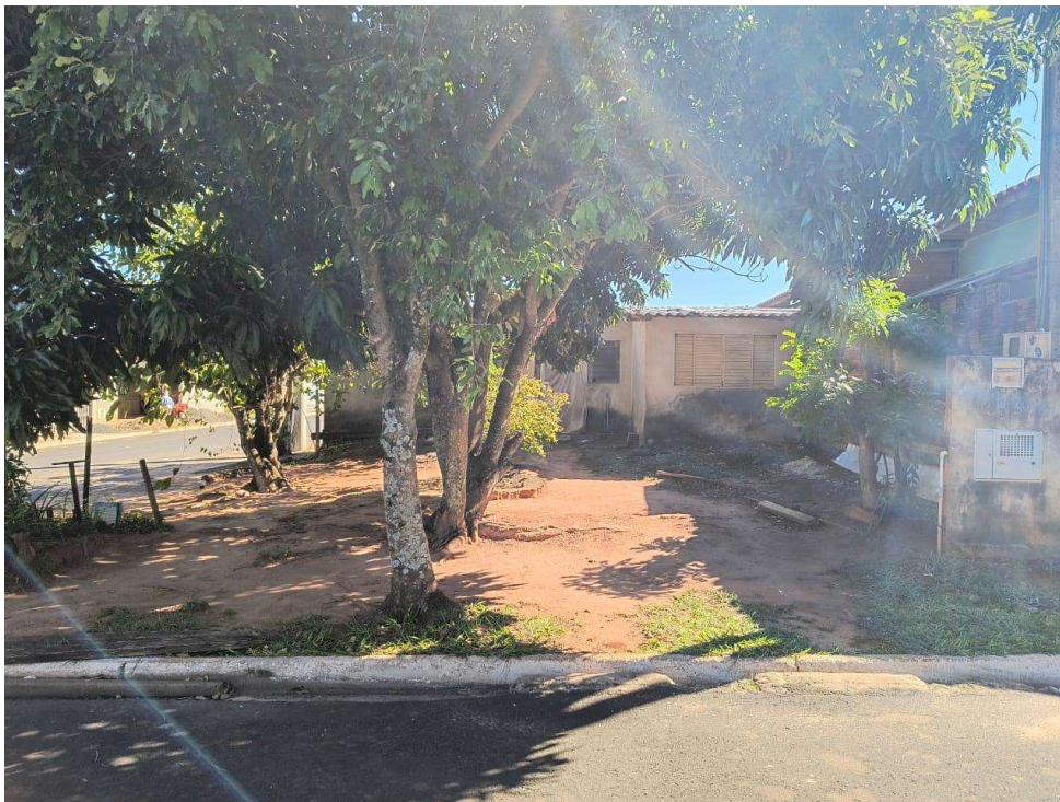
Vista Frente do Imóvel.
