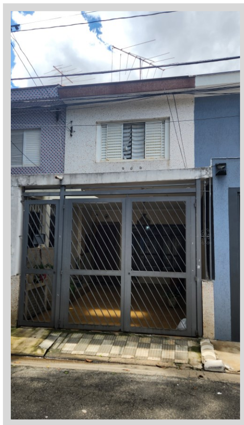
Fachada do imóvel avaliando: Rua José Romano nº 72.
