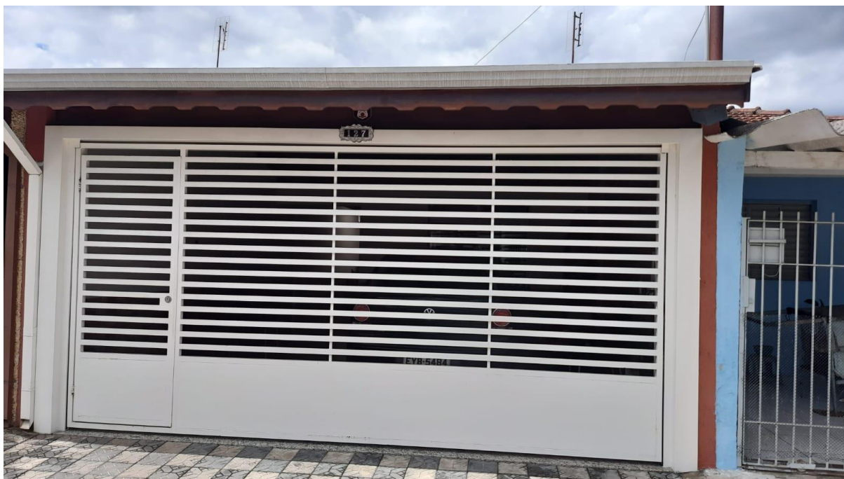
Fotografia 2: Fachada do imóvel de número 127 da rua João Alves, Jardim São Dimas
