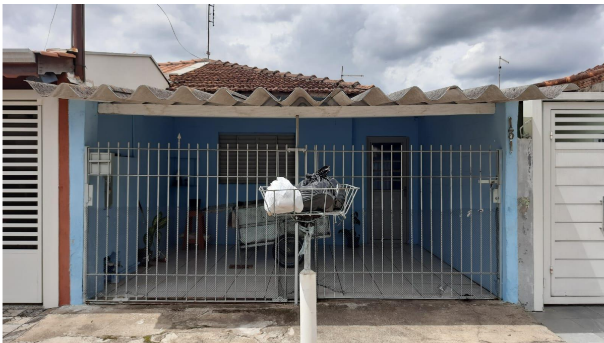
Fotografia 3: Fachada do imóvel de número 131 da rua João Alves, Jardim São Dimas
