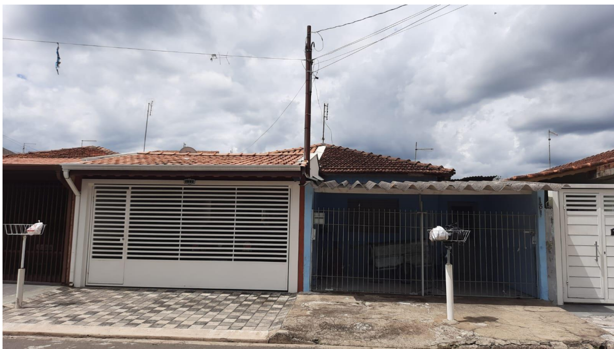
Fotografia 1: Fachada dos imóveis de números 127 e 131 da rua João Alves, Jardim São Dimas
