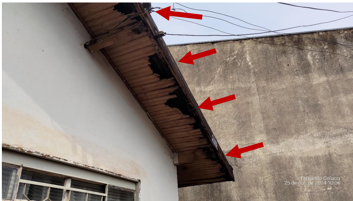
Figura 20 - Beiral em estado de apodrecimento
