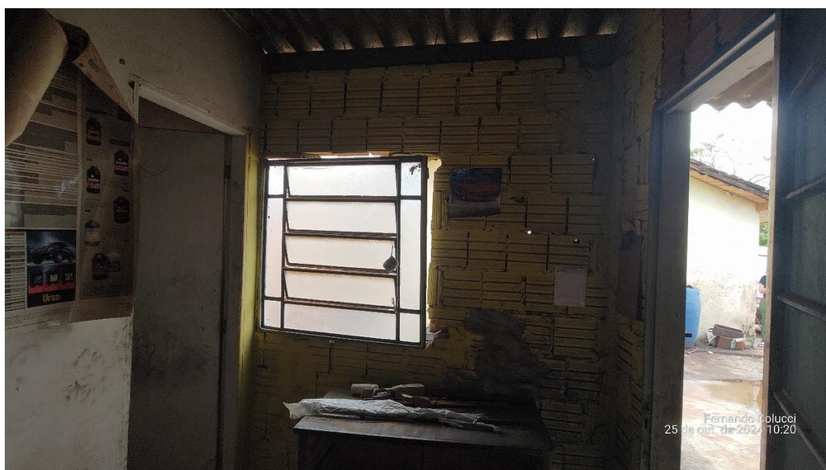
Figura 17 - Vista interna da ampliação
