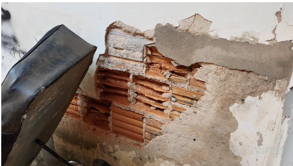
Figura 28 - Parede com tijolos a mostra
