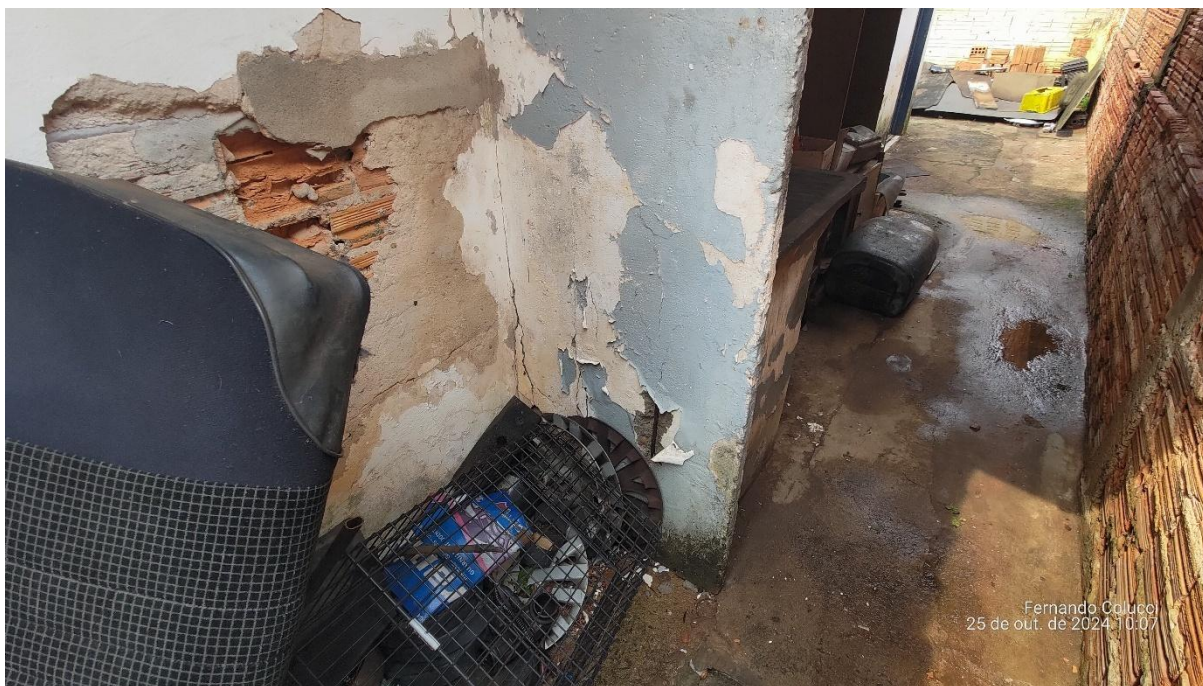
Figura 27 - Parede com tijolos a mostra
