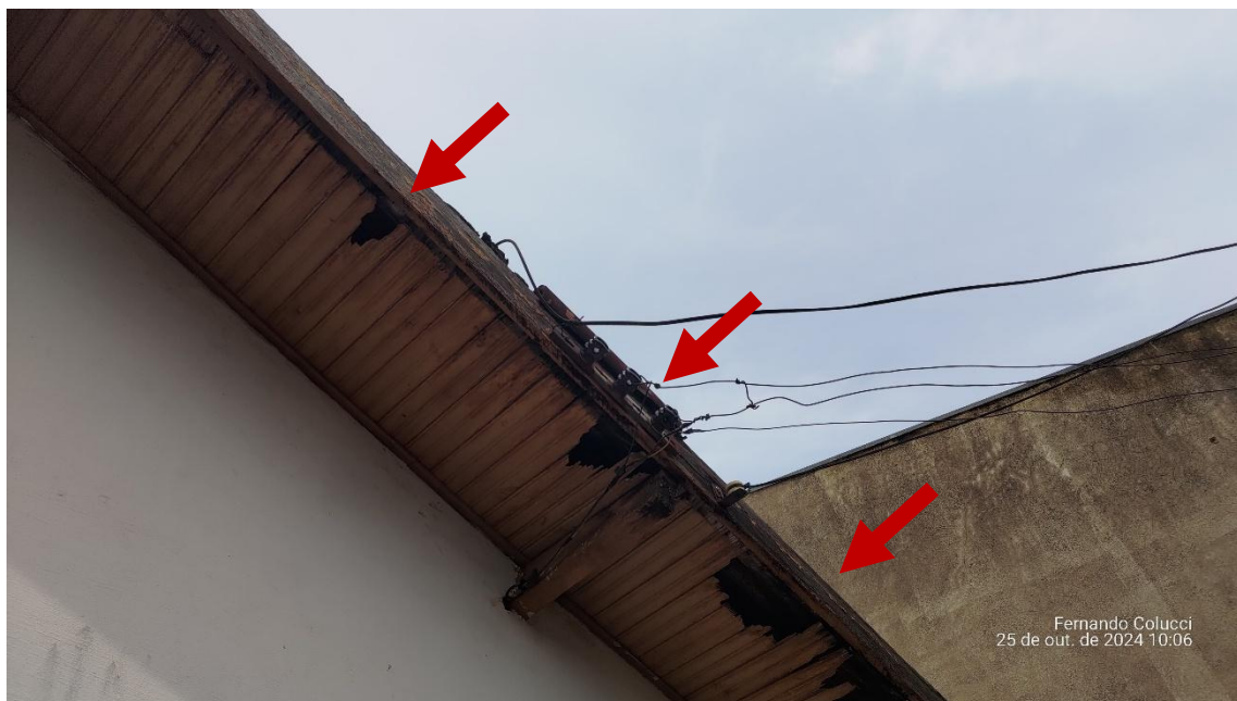
Figura 20 - Beiral em estado de apodrecimento
