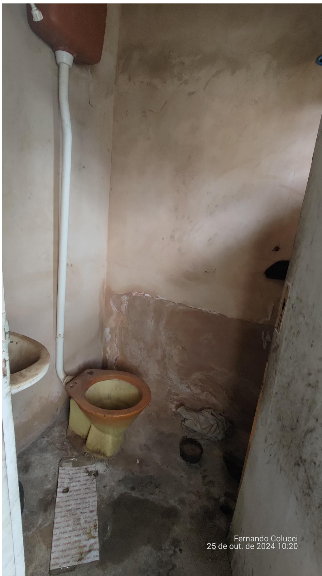
Figura 18 - Banheiro da ampliação
