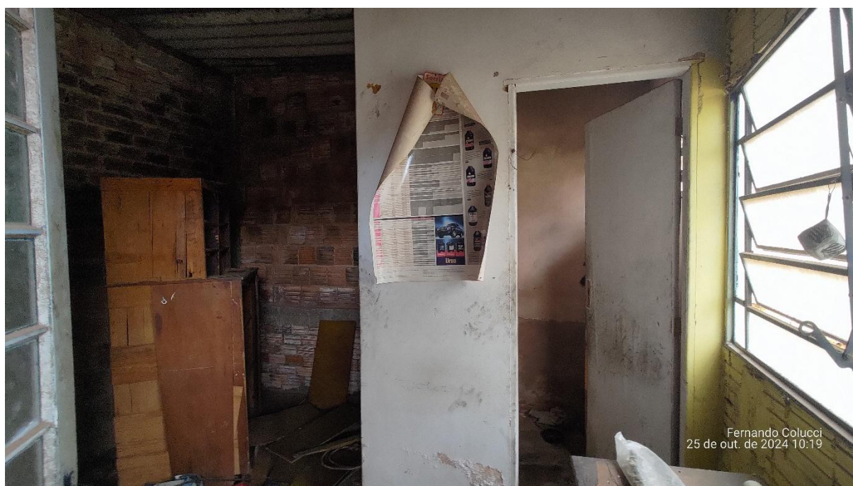
Figura 16 - Vista da ampliação
