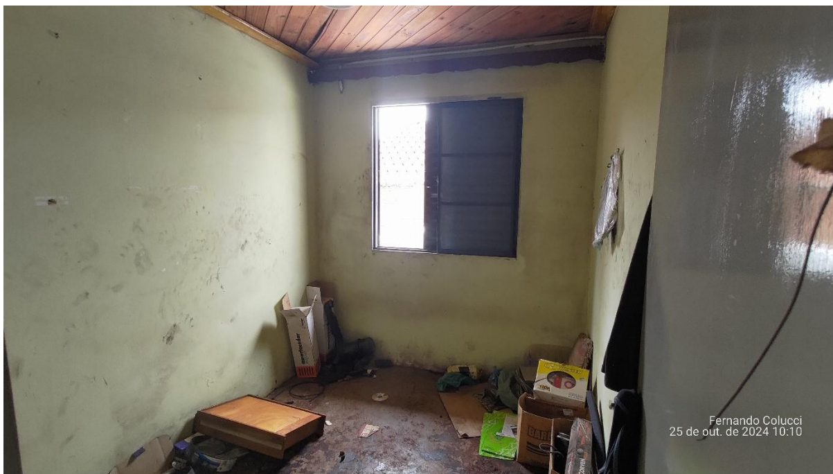
Figura 10 - Quarto - Vista da porta
