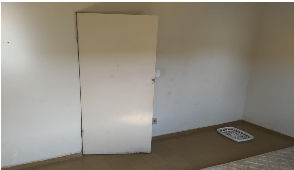
Fig. 10: Dormitório 01 Imóvel Avaliado.
