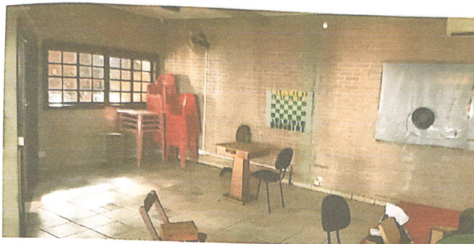
Vista interna da edificação (sala – Rua José Joaquim de Oliveira 177).
