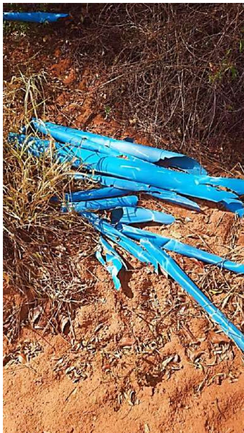
Foto 61. Mais irrigação destruída.
