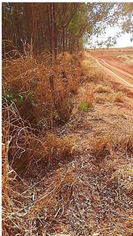
Foto 53. Cercas sem manutenção.
