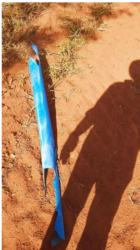
Foto 29. Mais irrigação danificada.
