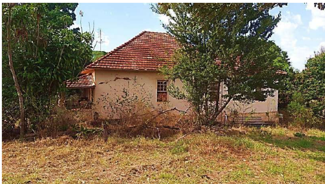
Foto 36. Aspectos de total abandono.
