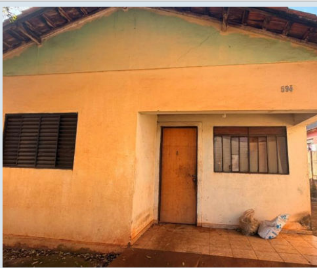
Foto 2 – Frente da Residência
