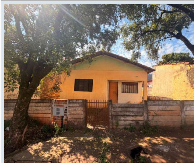
Foto 1 – Fachada do Imóvel Avaliando
